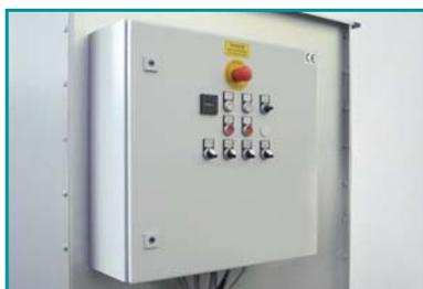
De intelligente PLC besturing regelt de procesafloop en is bedieningsvriendelijk in te stellen.
