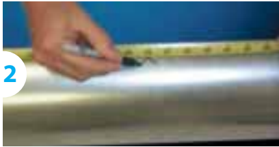
2 Noteer de benodigde afstand, min 100 mm.
