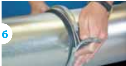
6 Vergrendel de QF verbindingklem over de rubberen ring en één uiteinde van de buisafronzing.
