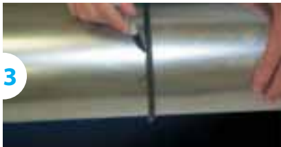
3 Gebruik de meegeleverde rubberen ring en markeer het snijpunt.
