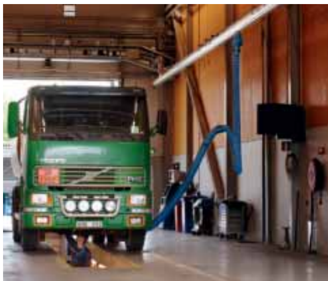
Voorbeeld uitlaatgasafzuigsysteem voor keuringscentrum.
